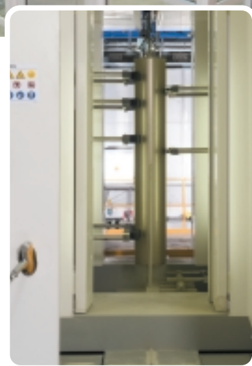
High-Tech im Einsatz - Bewegliche Lanzen garantieren selbst im Rohrrinnern eine durchgängige Qualität der Schutzbeschichtung.
